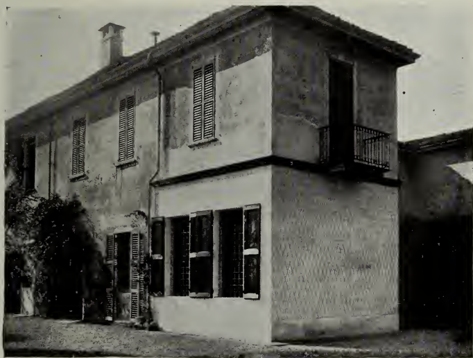
Veduta esterna dell'ala di fabbrica contenente la Cappella.
